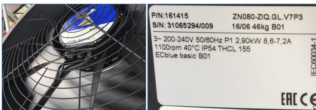
Figura 3.5 – Motores dos ventiladores EC Fonte: Autoria da ESCO
