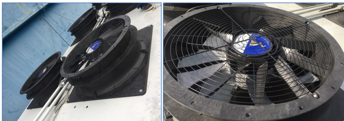
Figura 3.4 – Depois da AEE – ventiladores EC Fonte: Autoria da ESCO
